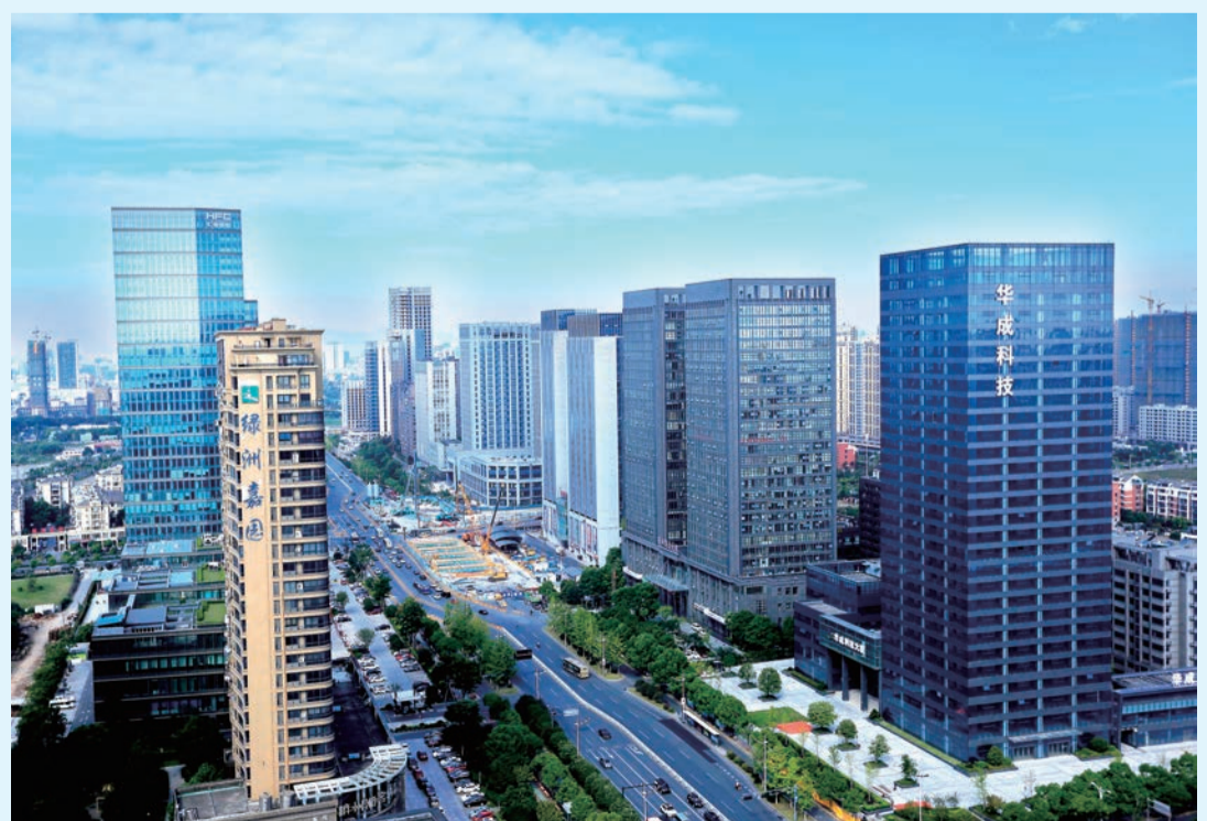
图中心施工区域即为博奥路站。
